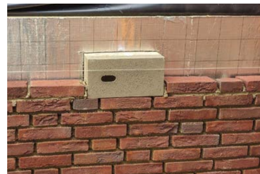
Mauerseglernisthilfe einbauen
