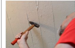
Abbildung 2: Unebenheiten grob entfernen
