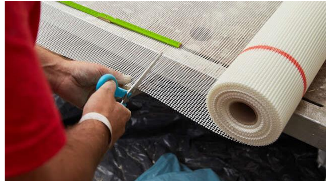
Armierungsgewebe zuschneiden
